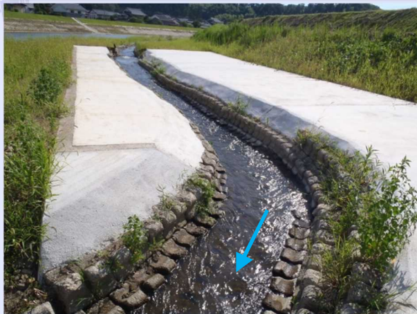
水路魚道整備状況
