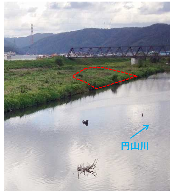
緩傾斜化+根固め工
