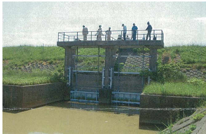
小樋排水樋門 (H28. 5. 8点検)
