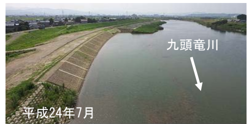
H24工事完成後
