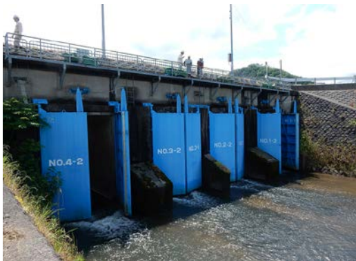
未更毛水閘点検の実施状況（H28.5.25）
