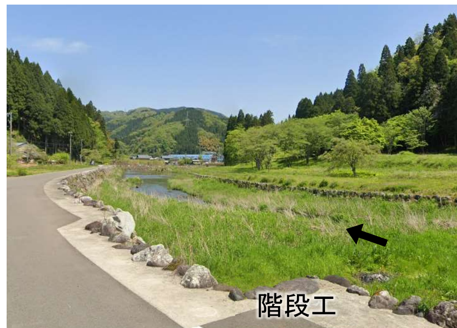
改修後（足羽川合流点より0.5km付近）
