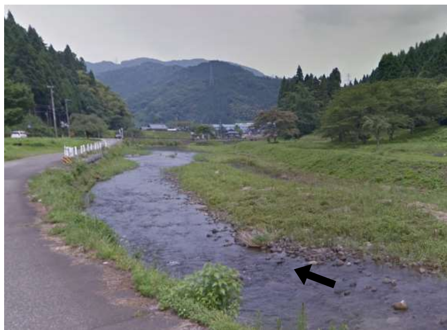
改修前（足羽川合流点より0.5km付近）
