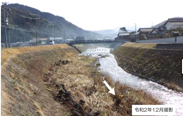
堆積土砂の除去（河和田川 鯖江市落井町）
