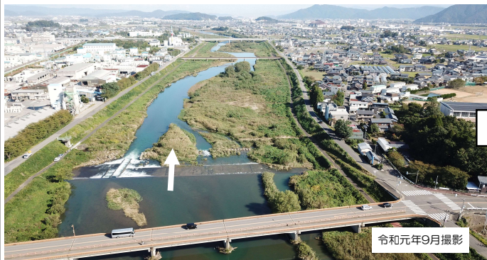
樹木群の伐採（日野川 越前市八幡1丁目他）
