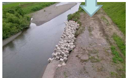
土砂で埋め戻した後、 根固ブロックで浸食 防止措置を実施。
