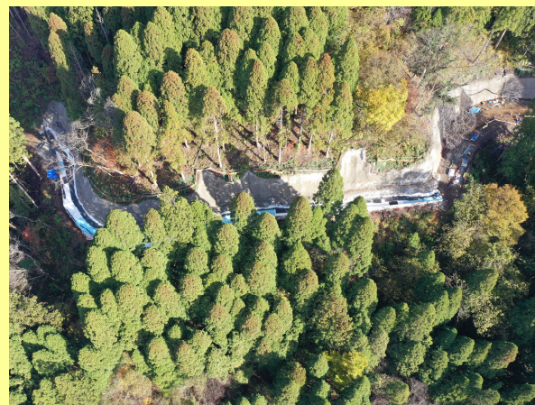
付替町道下荒谷線 改良工事(R5.11)
