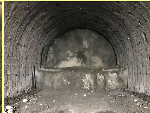
水海川導水トンネル 2期工事(R5.11)
