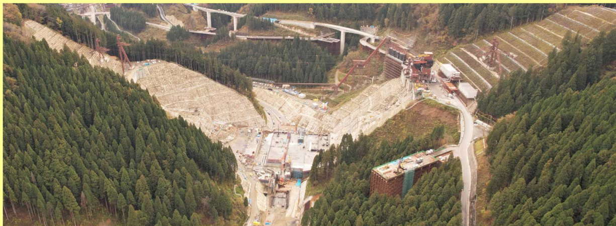
足羽川ダム本体建設(第1期)工事(R5.11)
