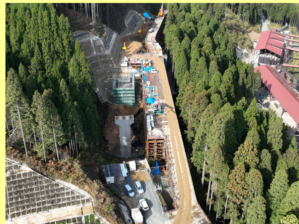
付替県道松ヶ谷宝慶寺大野線 10号橋工事(R5.11)
