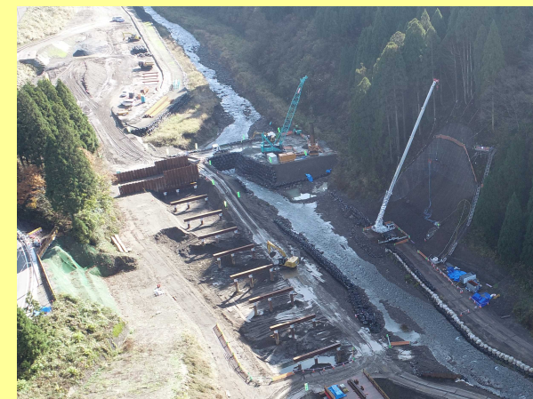
水海川貯砂ダム工事(R5.11)
