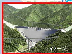
足羽川ダム建設（国）
