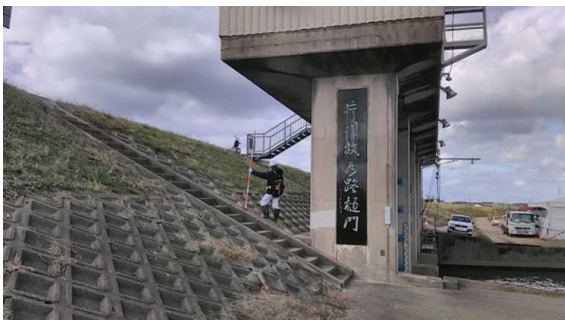
片川放水路樋門点検の実施状況 (R4. 11. 14)
