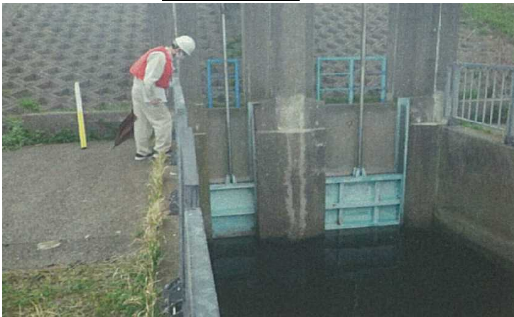
九頭竜川排水樋門(令和4年4月14日 点検)
