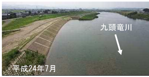
H24工事完成後
