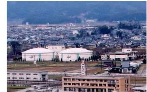
鯖江市上水道管理センター（鯖江市上鯖江町）
