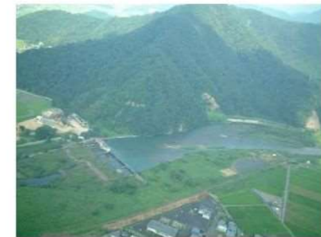
日野川 松ヶ鼻堰(越前市向新保町)
