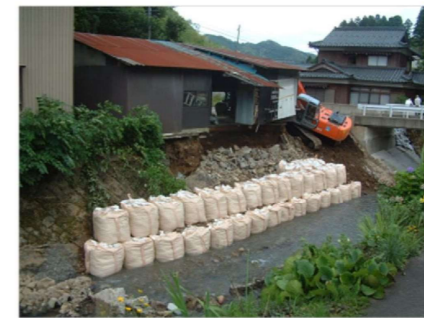
越知川 応急復旧（越前町上糸生）
