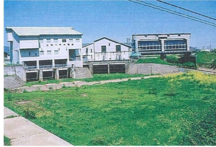
江端川 排水機場と逆流防止水門 (福井市江守の里)
