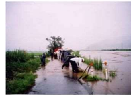
鞍谷川流域(鯖江市松成町付近) 平成10年7月10日 出水
