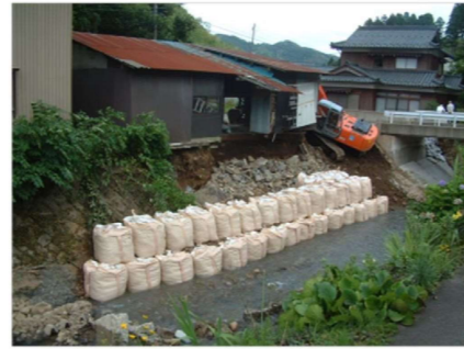
越知川 応急復旧（越前町上糸生）
