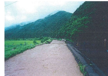
鹿蒜川流域(南越前町南今庄付近) 平成10年7月10日 出水
