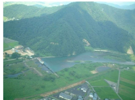
日野川 松ヶ鼻堰(越前市向新保町)
