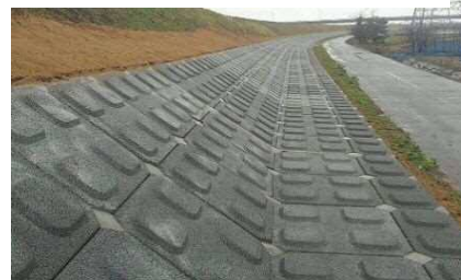
法尻補強の実施例(高屋地区)
