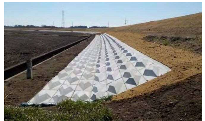
法尻補強の事例(久慈川)
