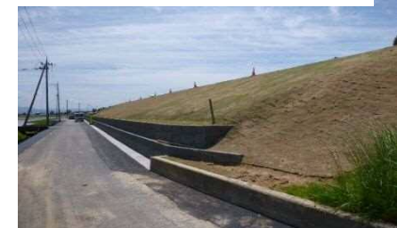
堤防強化の実施例(安沢地区)
