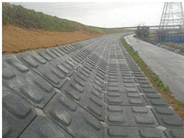
堤防裏法尻補強（高屋地区）
