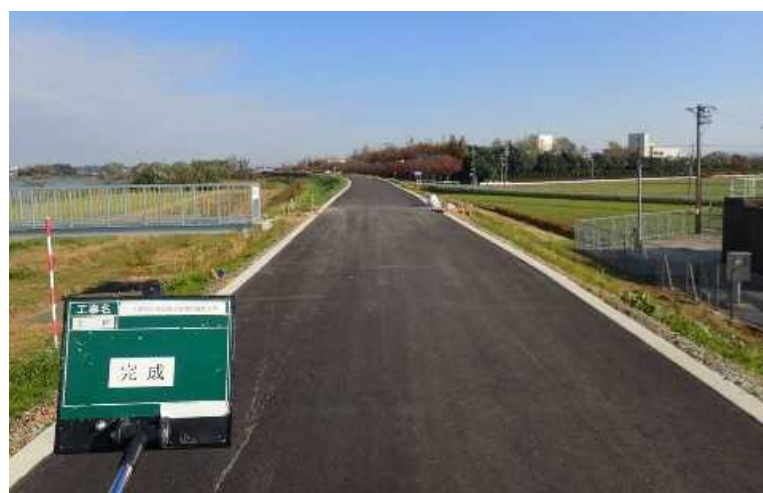
天端保護箇所(池見地区)
