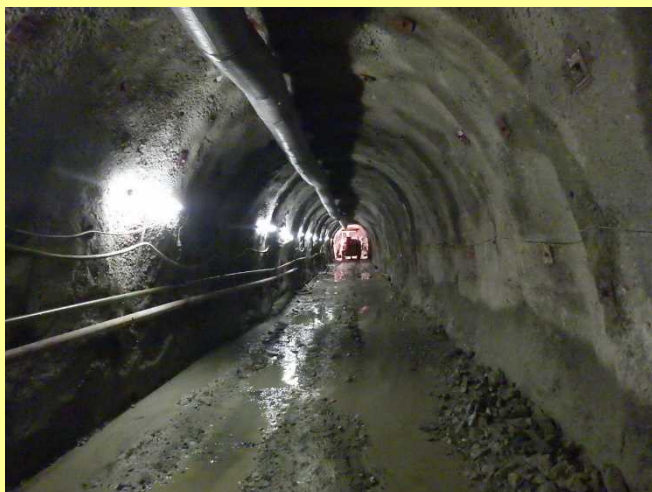
足羽川ダム転流工事 (H30.12)
