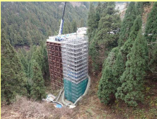
付替県道7号橋工事 (H30.12)
