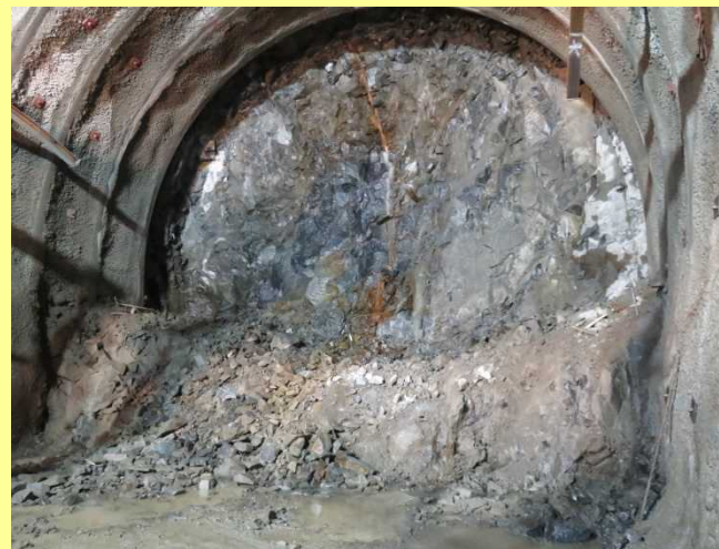
水海川導水トンネル I 期工事 (H30.12)
