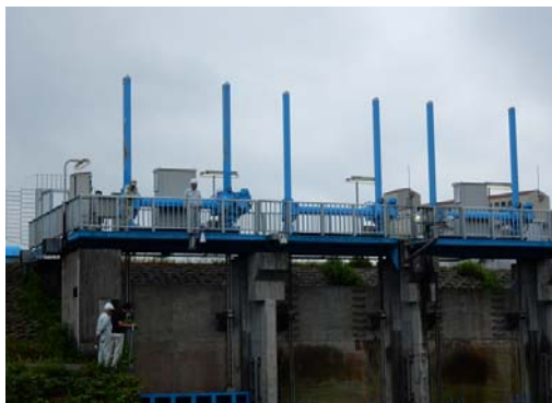
狐川樋門点検の実施状況（H29. 5. 25）
