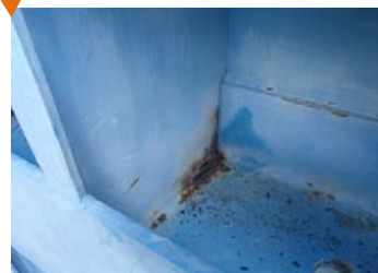
戸当損傷、塗装劣化
