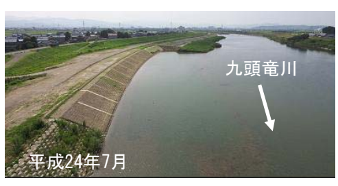
H24工事完成後
