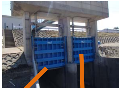
戸当損傷、塗装劣化
