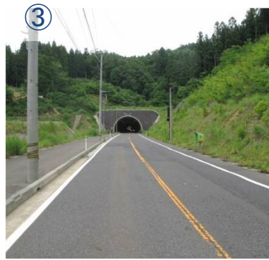
笠倉トンネル H21.3月供用
