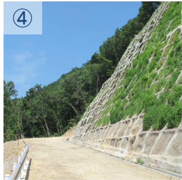
工事用道路 H29.5月
