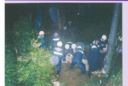
平成16年10月(台風23号)による被害 (右岸堤防漏水応急対応状況)
