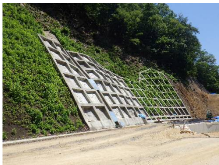
法面緑化を早期に実施
