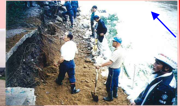
左岸堤体応急復旧状況
