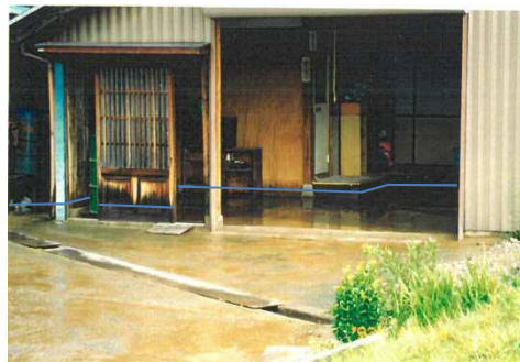
平成10年 9月 (台風) 浸水被害状況(家久町)
