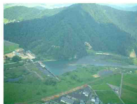
日野川 松ヶ鼻堰（越前市向新保町）
