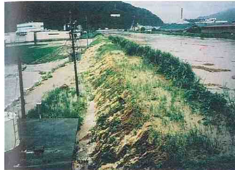
浅水川流域 (鯖江市鳥羽町付近) 平成 10 年 7 月 10 日 出水
