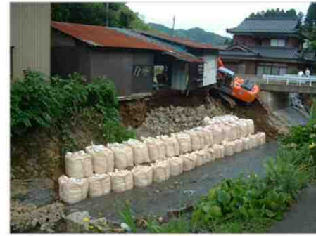
越知川 応急復旧 (越前町上糸生)
