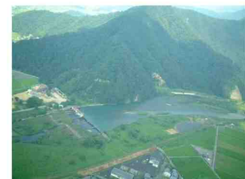
日野川 松ヶ鼻堰（越前市向新保町）
