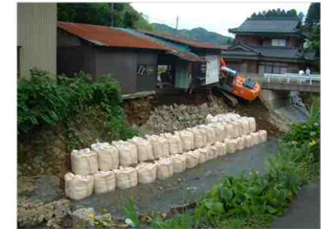
越知川 応急復旧 (越前町上糸生)
