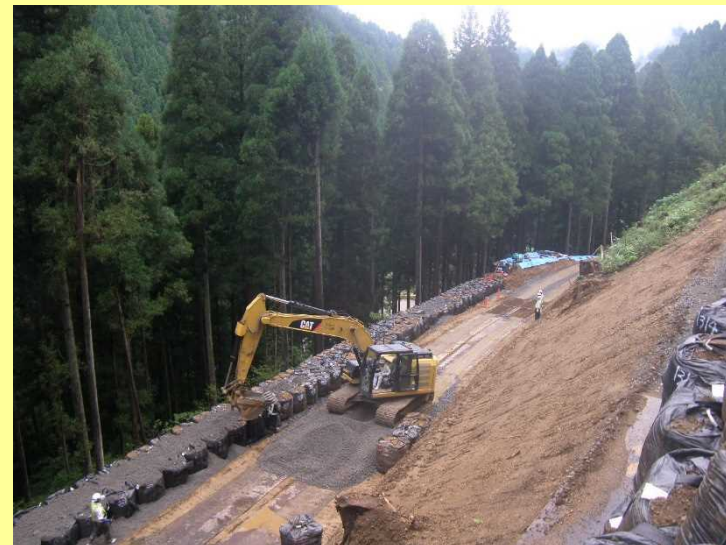
4号工事用道路 (H28.9)
