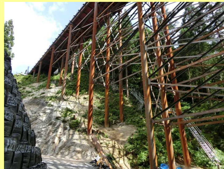
1号工事用道路 (H28.8)
