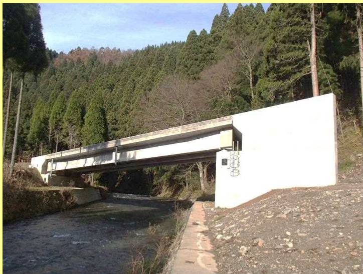
付替県道1号橋 (H27.12完成)
