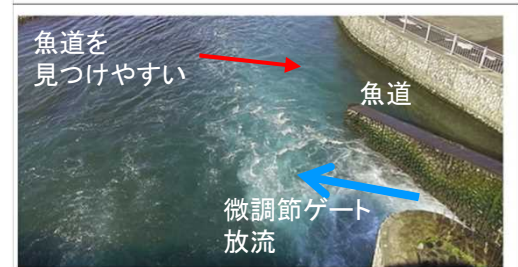
流量調節時(5.0m 3 /s)の放流状況
