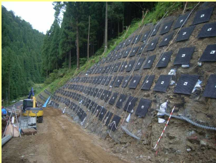
2号工事用道路 (H28.9)
