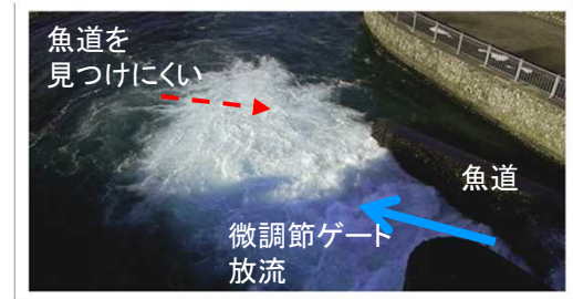
通常時(15.0m 3 /s)の微調節ゲート放流状況
