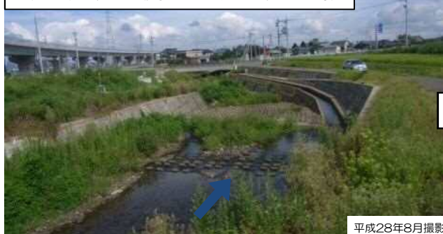
堆積土砂の除去（荒川 永平寺町松岡吉野）
