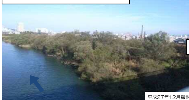
樹木群の伐採（足羽川 福井市西方）
