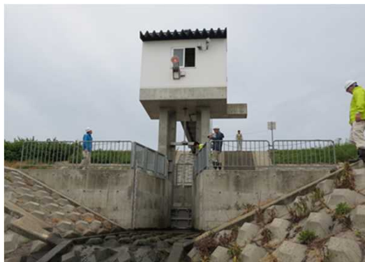
片粕排水樋門点検の実施状況（H26.5.12）
