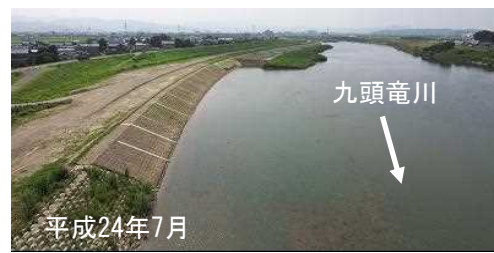
H24工事完成後
