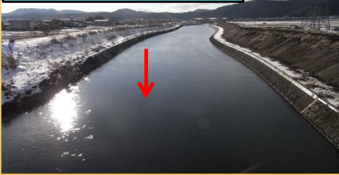
左岸改修済み区間
