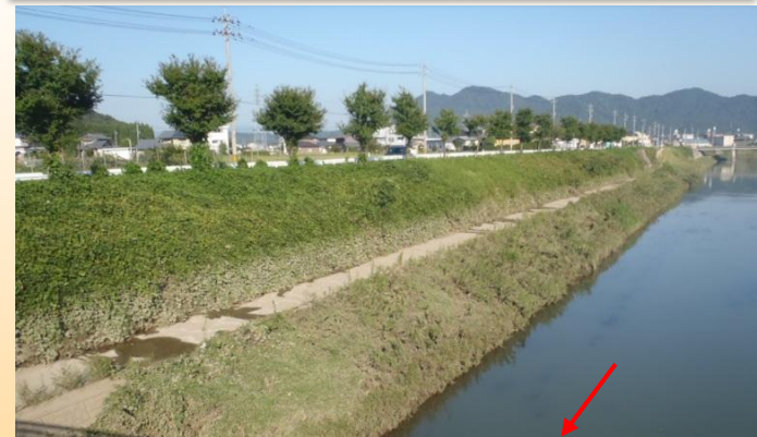
法肩部の河畔樹木の整備状況(市街地区間)
