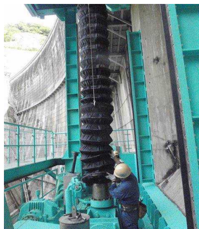
定期点検の実施状況
