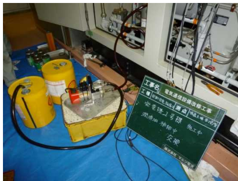
発電機のオーバーホール
