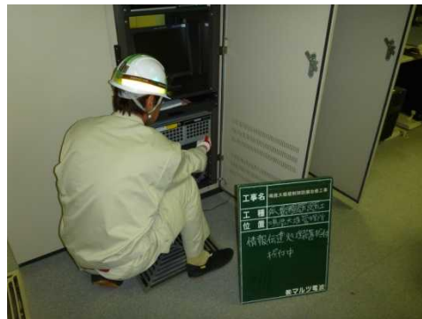
制御処理設備の改修
