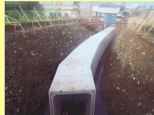
施工状況写真 (左支川)
