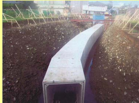
施工状況写真 (左支川)
