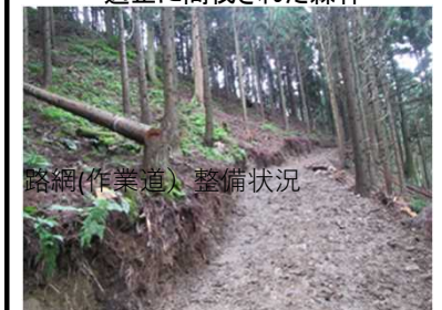
路網(作業道)整備状況
