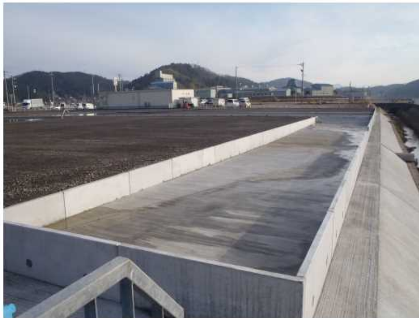
開発に伴い設置する調整池
