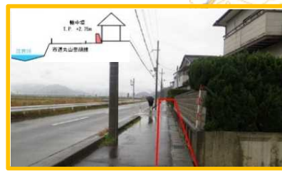
江古川地区の輪中堤整備(福井県)
