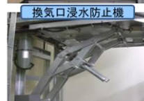
地下への浸水防止対策
