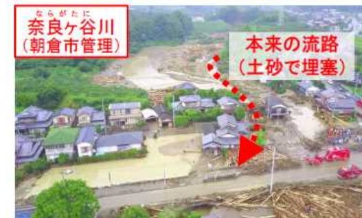
国が準用河川の災害復旧を代行することが想定される例 （平成29年九州北部豪雨（福岡県・筑後川水系））
