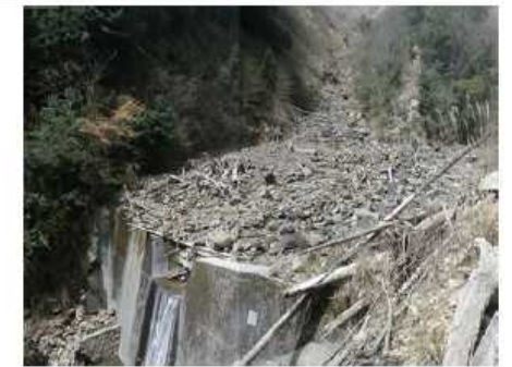
治山ダムが山腹崩壊と土砂流出を軽減した事例【大分県日田市】
