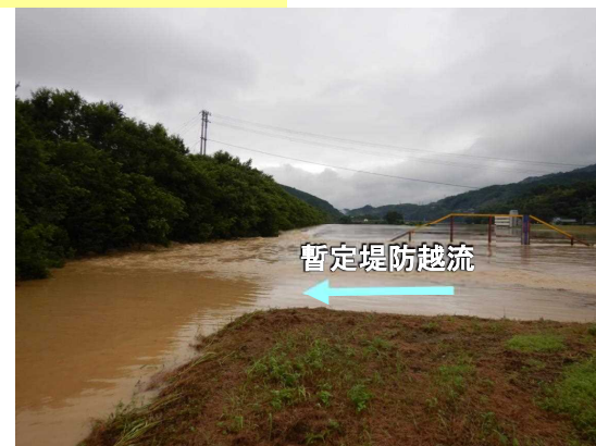
暫定堤防越水状況
