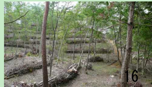
過密林の伐採後に土留工を設置
