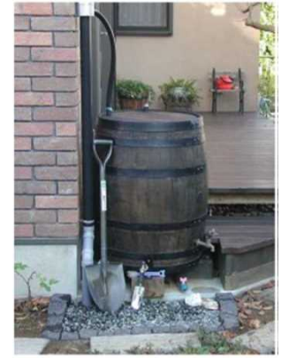
雨水貯留タンクの設置例
