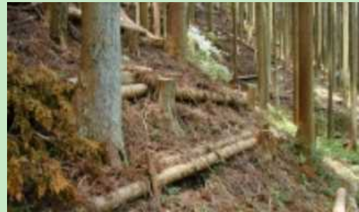
間伐材を利用した土留工の設置例
