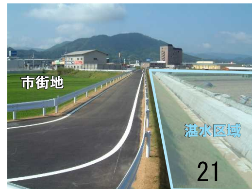
二線堤整備状況
