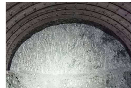
【本坑】勝原IC側切羽の状況 (R4.1: 支保パターンD I)
