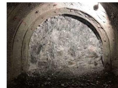
【避難坑】勝原IC側切羽の状況 (R4.1: 支保パターンD I)
