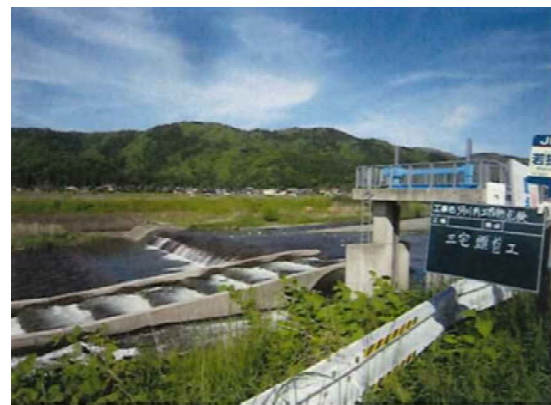
三宅頭首工（R1.5.8 点検）
