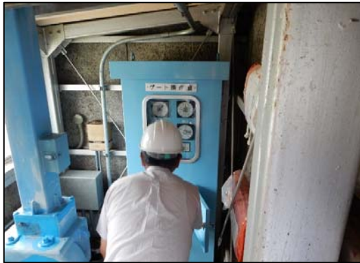
平井川樋門点検の実施状況（R1.6.10）
