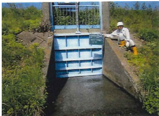
瓜生第一排水樋門（R1.5.8 点検）
