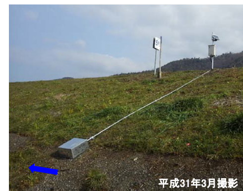
北川右岸5.8k 若狭町下野木
