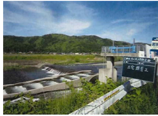
三宅頭首工（R1.5.8 点検）
