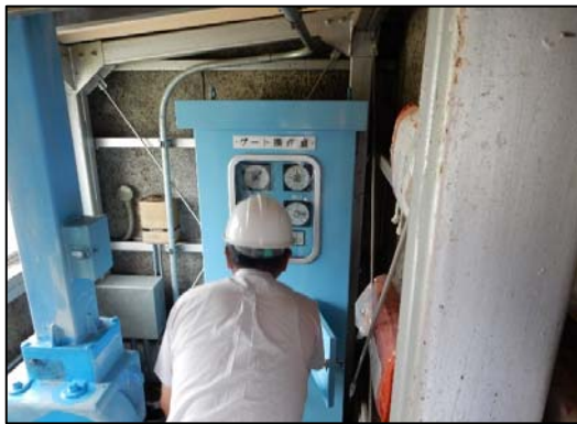
平井川樋門点検の実施状況（R1. 6. 10）
