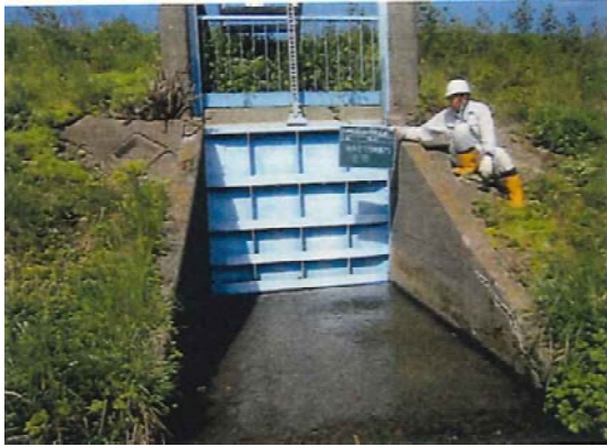
瓜生第一排水樋門（R1.5.8 点検）
