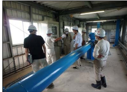
樋門監査の様子 令和2年8月
