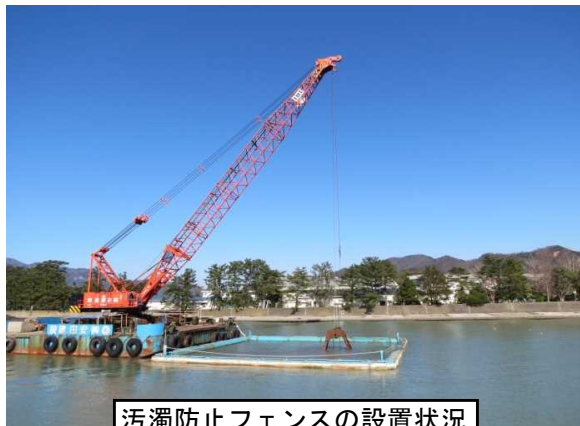
汚濁防止フェンスの設置状況
