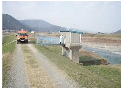
河川巡視の実施状況
