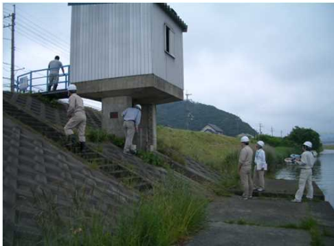
樋門点検の実施状況
