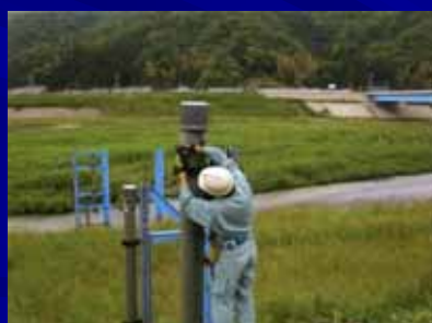
水位観測所の点検
