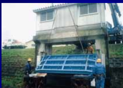
水門・樋門ゲート点検
