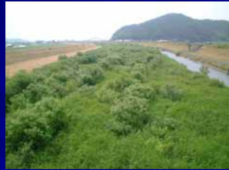
河道内樹木の繁茂
