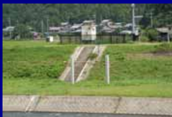
天徳寺水位観測所
