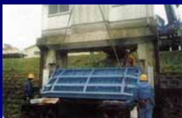
水門・樋門の点検
