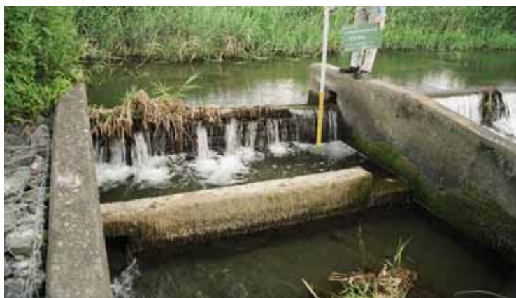
魚道機能が良好でない工作物（国富頭首工）
