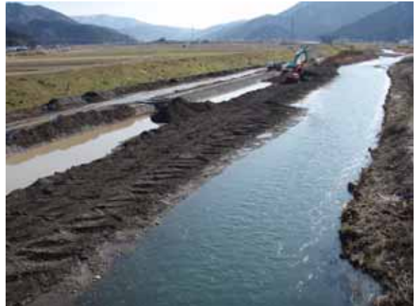
土堤締切により汚濁を防止している状況
