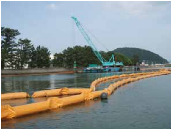
汚濁防止フェンスの設置状況
