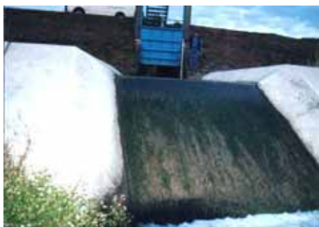
落差の大きい樋門
