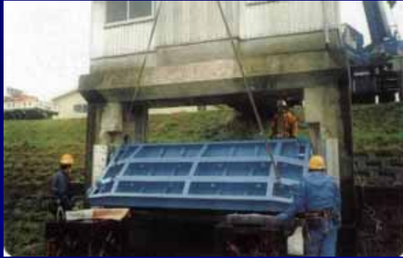
水門・樋門の点検
