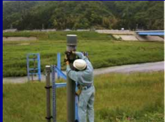
水位観測所の点検
