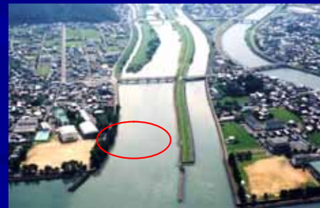
除去後の状況(H15.8)
