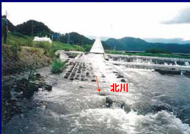
トラップ設置状況
