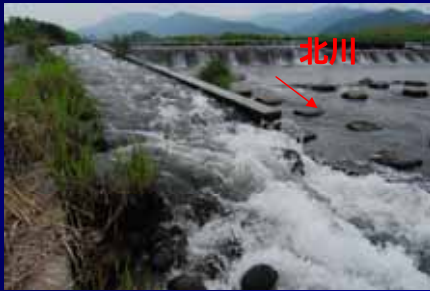
府中頭首工の魚道
