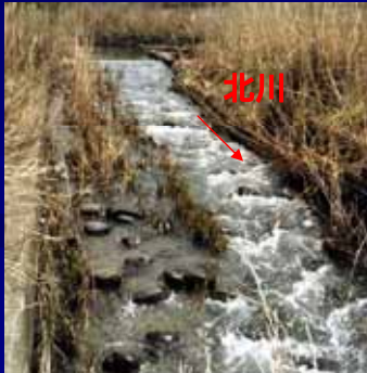
堤床固工の魚道
