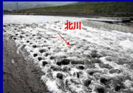
孫城床固工の魚道
