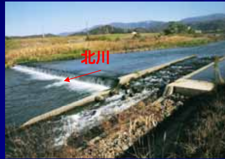
成之部床固工の魚道
