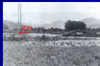
三宅橋の決壊状況
