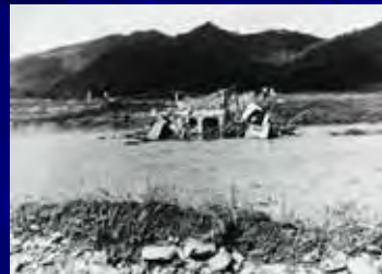
流失した丸山橋
