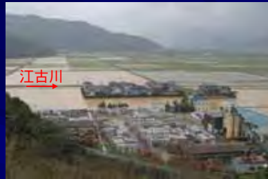
江古川流域の浸水状況
