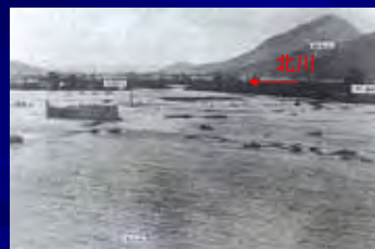
北川堤防決壊による天徳寺地区の浸水状況
