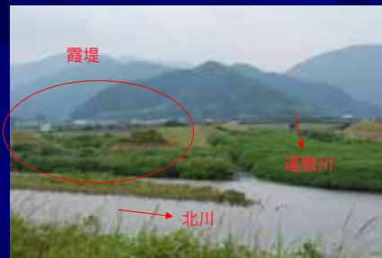
遠敷川合流の状況
