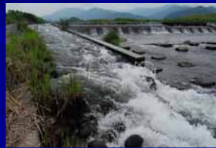
府中頭首工の魚道
