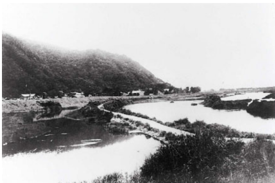
改修工事前の亀の甲付近
