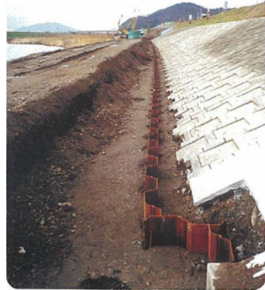
写真 1.2.7 漏水対策工事実施状況
