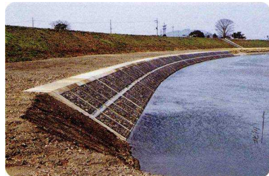
府中地区護岸工事後
