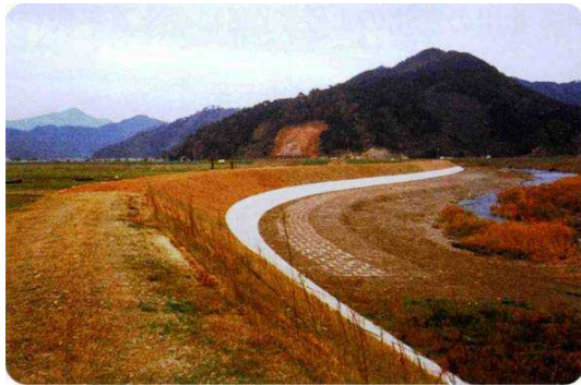
遠敷川左岸築堤・護岸工事後
