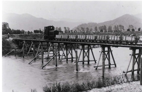
北川・江古川に架橋して築堤用の土砂を運搬する機関車
