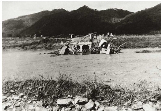
昭和28年9月台風13号 流出した丸山橋
