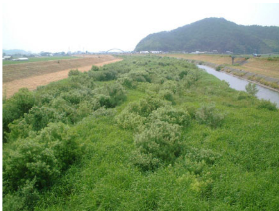
河道内樹木の繁茂
