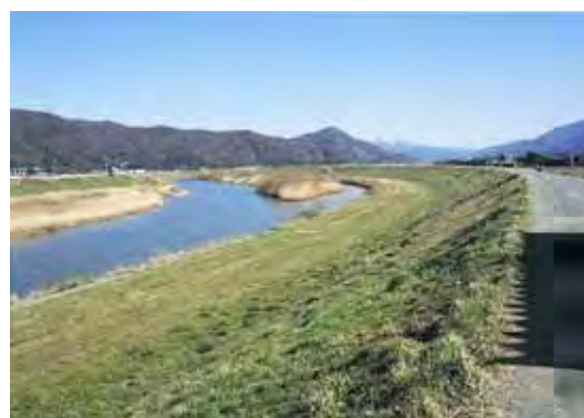
平成15年の左岸2.0kmより上流を望む
