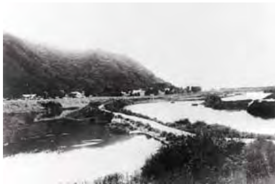
改修工事前の亀の甲付近
