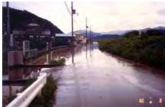
昭和57年8月台風10号 小浜市水取地区(右岸0.6k付近)の浸水状況
