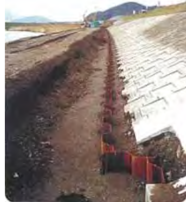
写真 1.2.7 漏水対策工事実施状況
