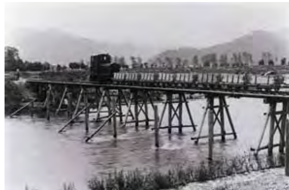
北川・江古川に架橋して築堤用の土砂を運搬する機関車
