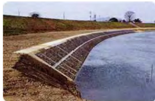
府中地区護岸工事後
