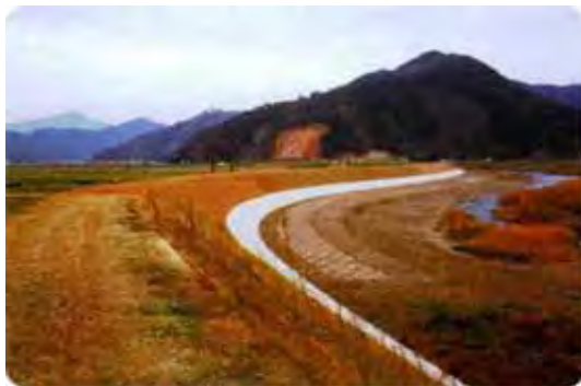
遠敷川左岸築堤・護岸工事後
