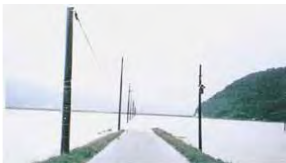
平成2年9月台風19号 北川4.0km付近右岸の霞堤からの 逆流による浸水状況(小浜市)
