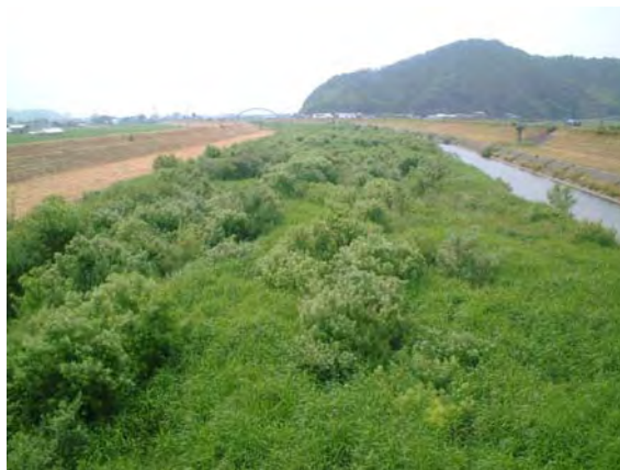
河道内樹木の繁茂
