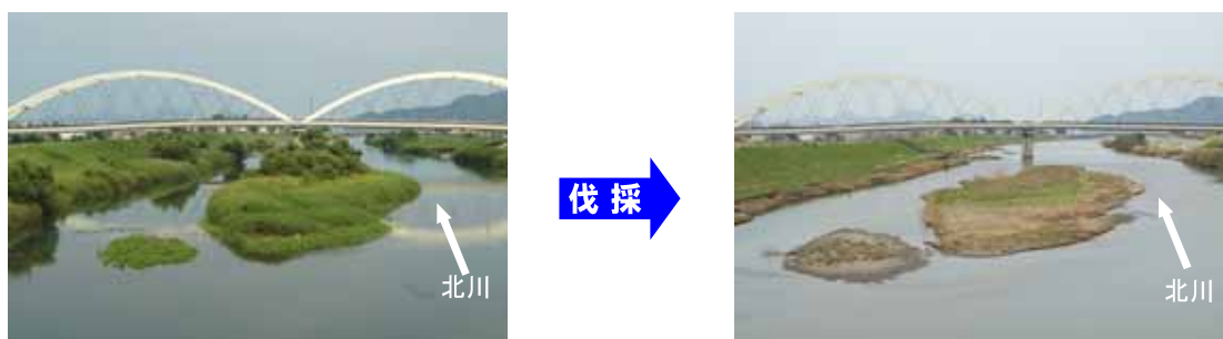
伐採前と伐採後の状況(こうのとり大橋付近)
