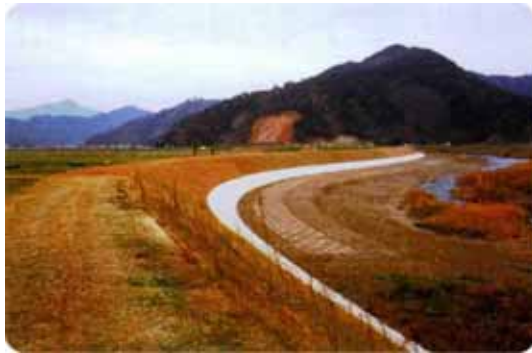
遠敷川左岸築堤・護岸工事後
