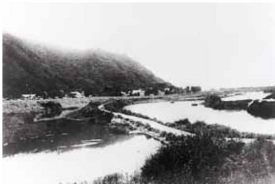
改修工事前の亀の甲付近
