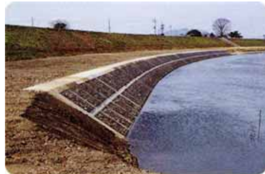
府中地区護岸工事後
