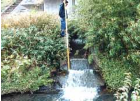
北川との落差 65cm (大鷲樋門)
