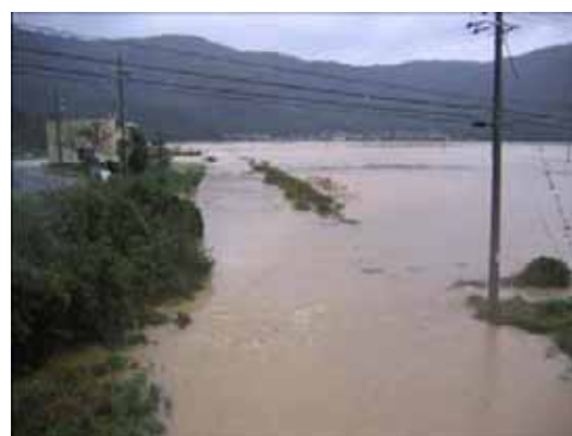
平成16年10月台風23号 小浜市太良庄地区の浸水状況
