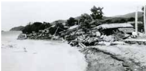
昭和28年9月台風13号 小浜市西津地区の惨状
