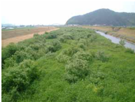
河道内樹木の繁茂
