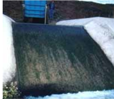
北川との落差 230cm (瓜生第 1 排水樋門)
