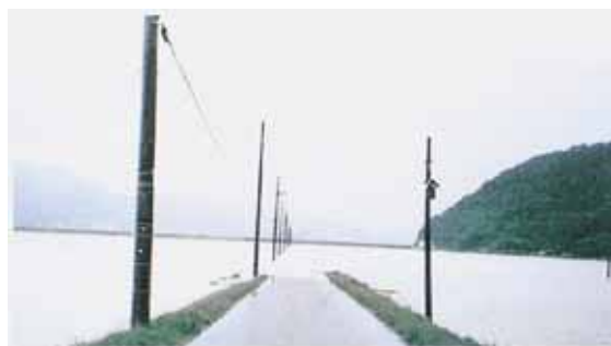
平成2年9月台風19号 北川4.0km付近右岸の霞堤からの 逆流による浸水状況(小浜市)
