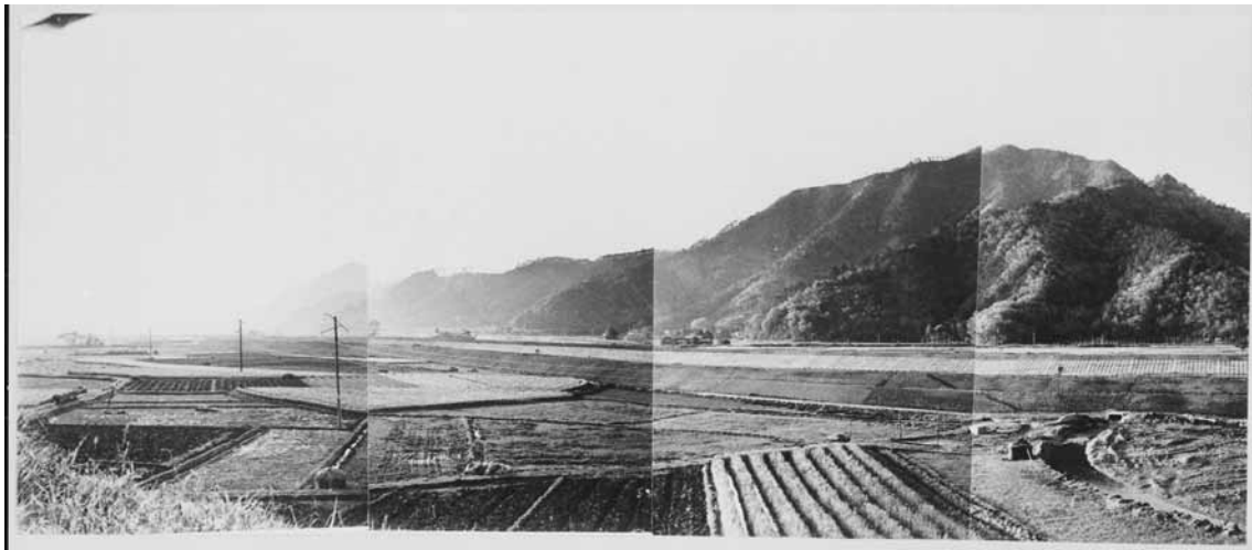
写真 1.2.4 北川堤防復旧工事完成の様子(平野～堤付近)
