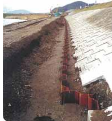
写真 1.2.7 漏水対策工事実施状況
