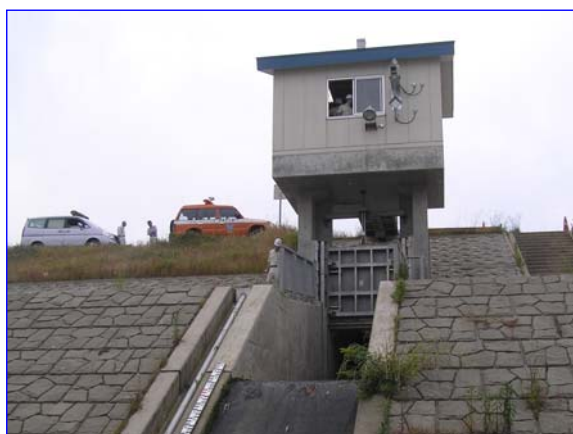
河川管理施設の点検状況
