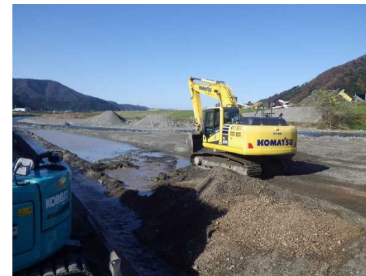
掘削作業風景
