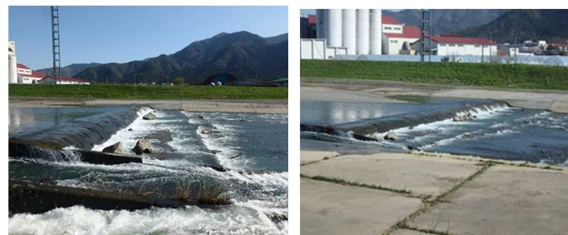
根固ブロックを使った落差緩和実験
