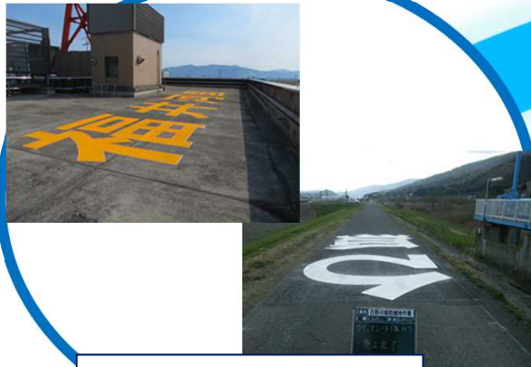
河川に対空 標示を設置
