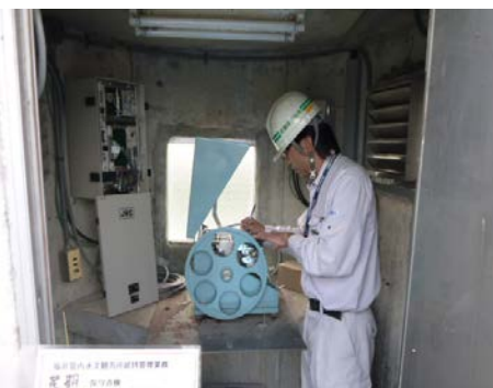
水位観測所点検状況
