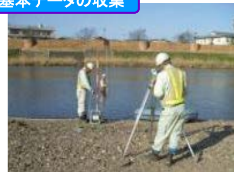
測量実施状況
