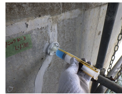
補修作業状況
