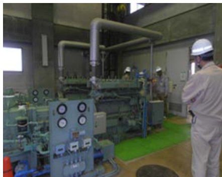
排水機場点検状況
