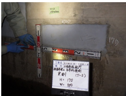
補修作業後の状況
