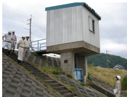
三味線堀樋門
