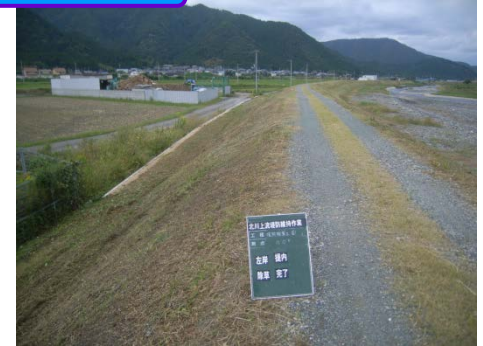
堤防除草後の状況
