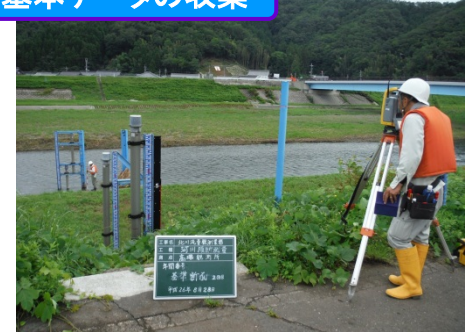
測量実施状況
