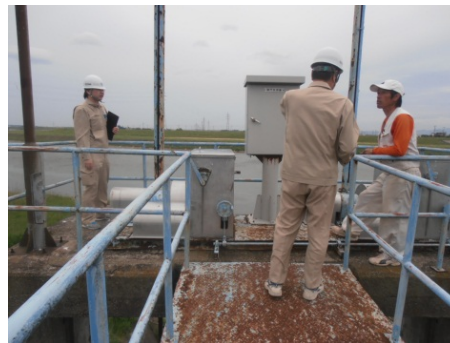
樋門点検状況
