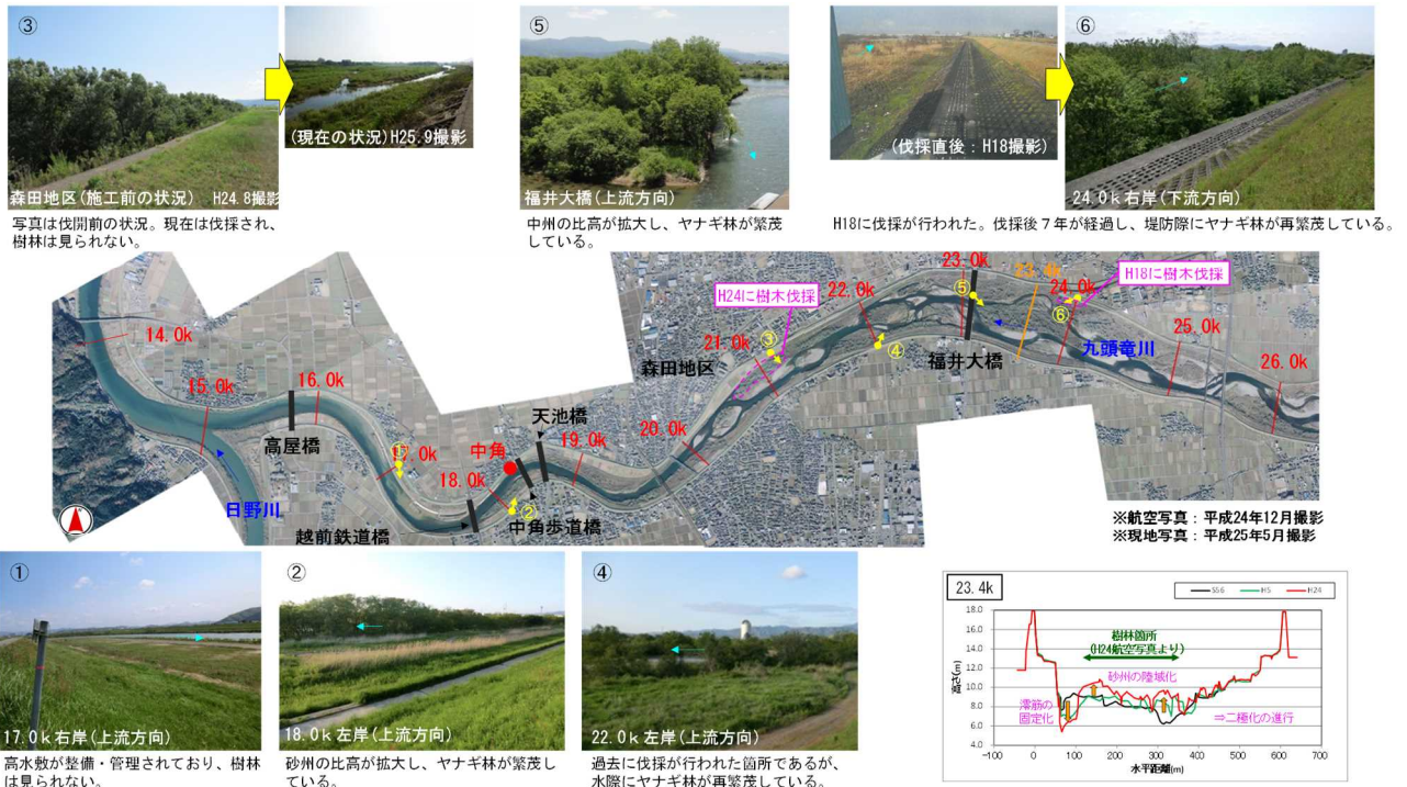
図 1.3.14 流下阻害となる河道内樹木の伐採状況 (九頭竜川 15k~25k 付近)
