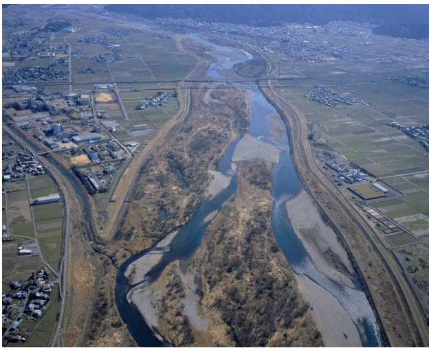
図 1.3.9 九頭竜川河道拡幅部 (25k 付近)
