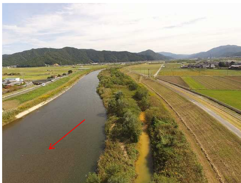
図 1.3.9 河道内樹木の繁茂状況（北川 1.6k 付近、平成 28 年 10 月）
