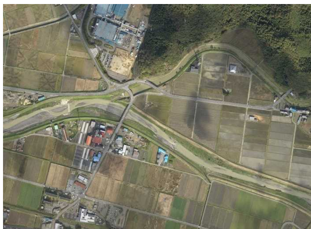
図 1.3.6 鳥羽川合流点（11k 付近）
