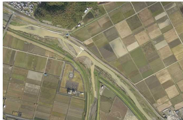
図 1.3.5 遠敷川合流点（4.3k 付近）
