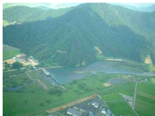
日野川 松ヶ鼻堰（越前市向新保町）
