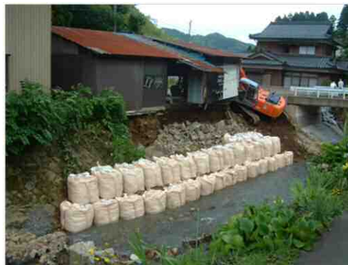
越知川 応急復旧（越前町上糸生）
