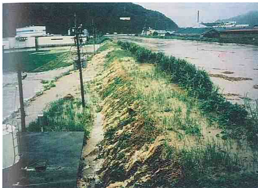
浅水川流域（鯖江市鳥羽町付近） 平成10年7月10日 出水
